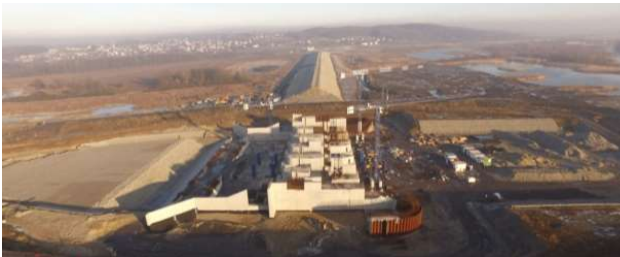
Fot 1. Widok na budowlę przelewowo – spustową, sztuczny wybój, kanał doprowadzający oraz nasyp korpusu zapory czołowej.
