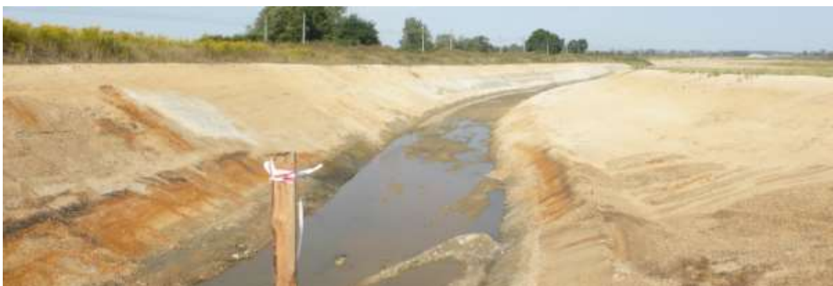
Fot 3. Wykop przełożonego koryta rzeki Psiny
