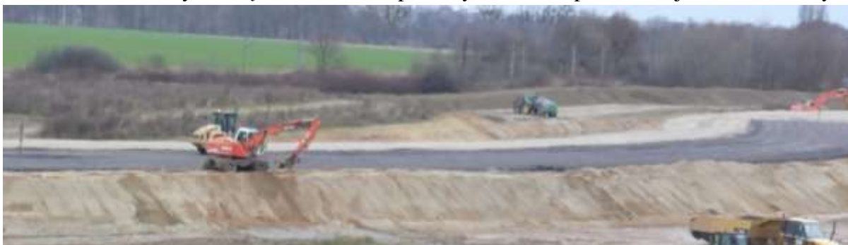
Fot 5. Budowa korpusu zapory lewobrzeżnej.
