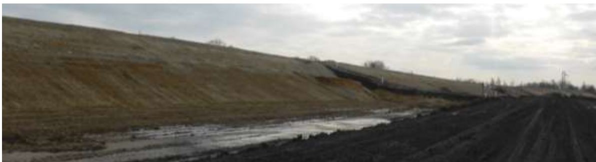
Fot 6. Budowa korpusu zapory prawobrzeżnej.
