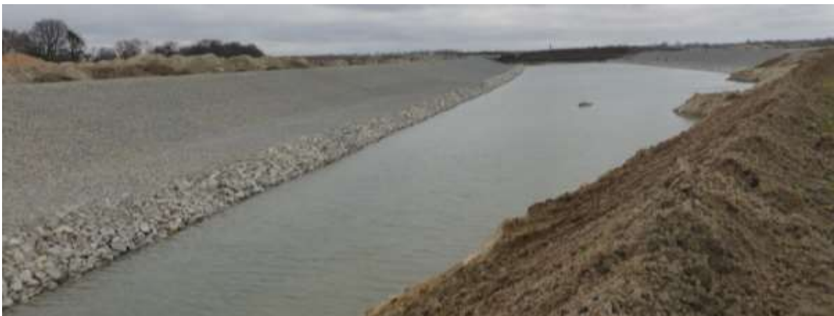
Fot 1. Wykop i umocnienie narzutem kamiennym oraz koszami siatkowo-kamiennymi kanału odpływowego.
