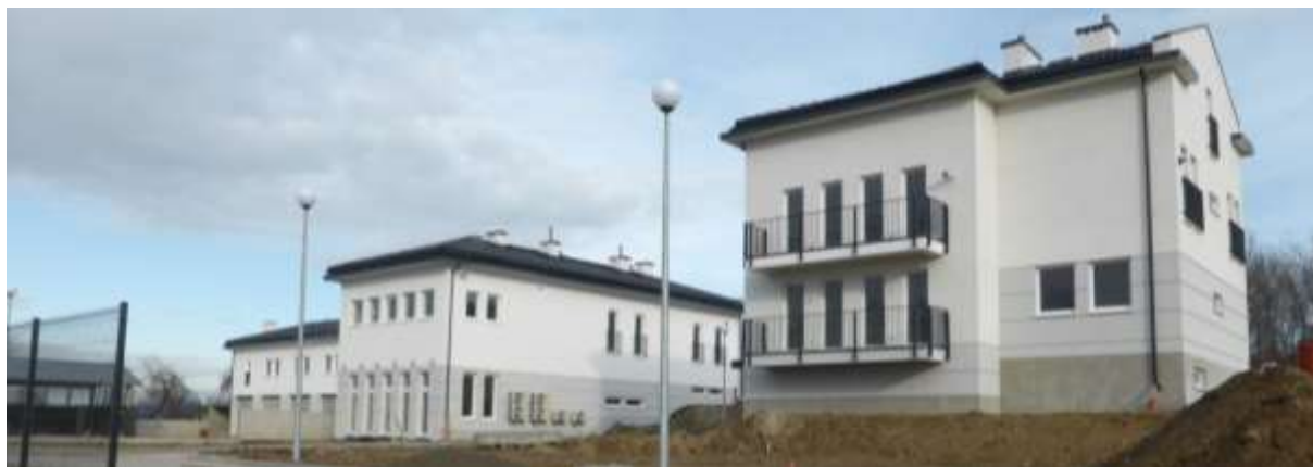
Fot 8. Budynki zaplecza eksploatacyjnego. Od prawej: budynek mieszkalny (411), administracyjny (412), garażowo-warsztatowy (413), wiaty magazynowa (414).
