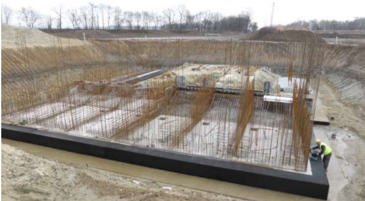
Fot 7. Budowa pompowni przy zbiorniku retencyjnym Buków
